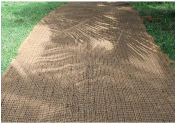
Böschungsbegrünung und Erosionsschutz in einem Muldengraben
