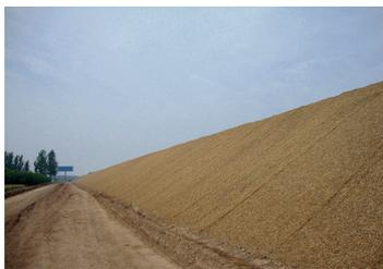
Erosionsschutz einer Böschung;
