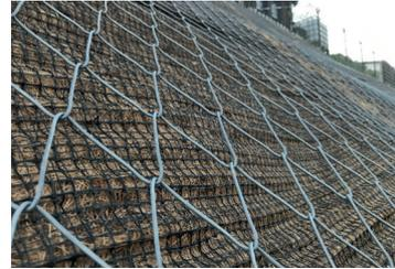
Böschungssicherung mit Vmax C350 mit einem zusätzlichen Steinschlag-schutznetz zur Fels-sicherung; Neigungswinkel 30-70°
