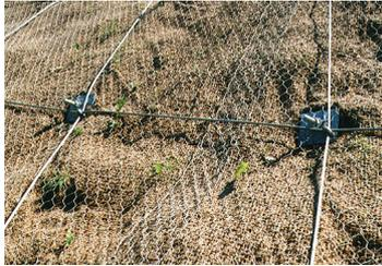
Böschungsbegrünung und Erosionsschutz mit zusätzlichem Steinschlag-schutz; Neigungswinkel 30-70°
