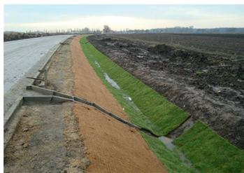
Erosionsschutz eines Entwässerungs-
