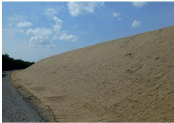
Böschungsbegrünung und leichter Erosionsschutz mit Jutegewebe;
