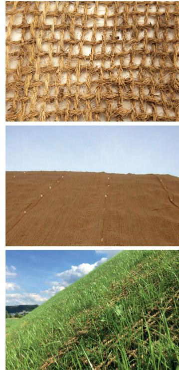
Begrünung und Erosionsschutz des Uferbereiches und des Retentionsraumes; Neigungswinkel 30-50°
